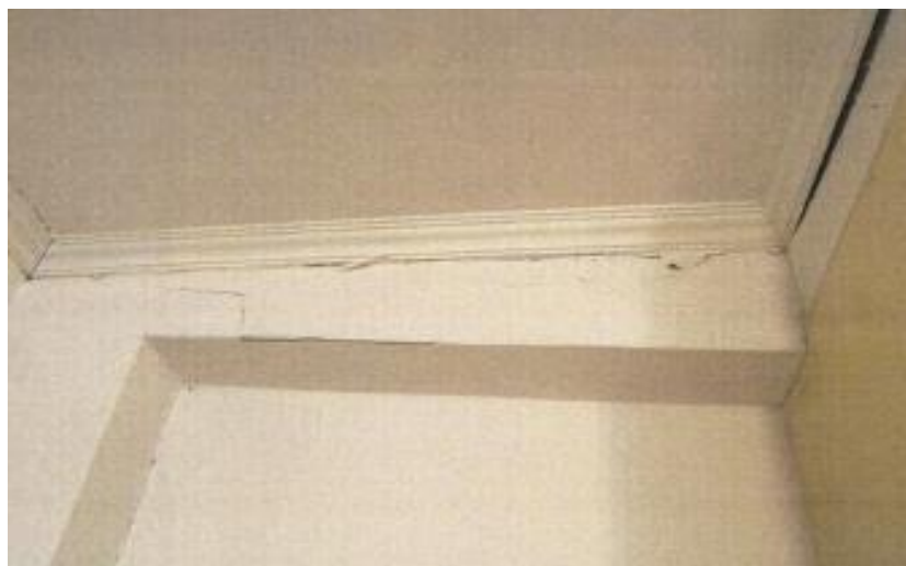
(說明: 樑鋼筋外露及裂縫)
