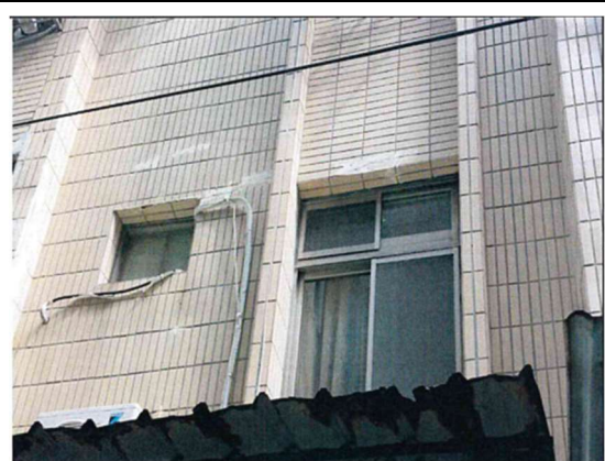
圖 13 建物現況照片 (6)
