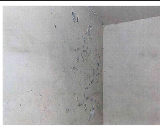
圖 12 建物現況照片 (5)
