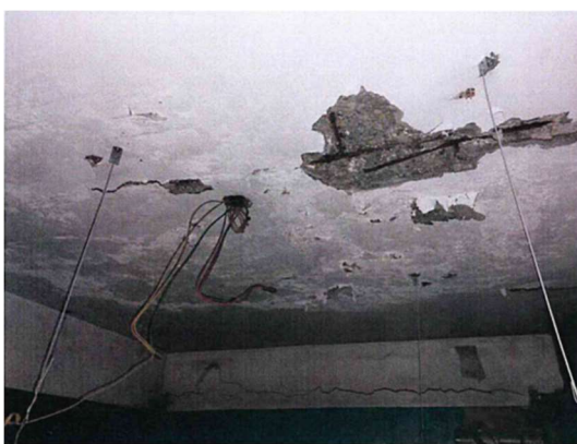
圖 11 建物現況照片 (4)
