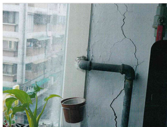
圖 10 建物現況照片 (3)
