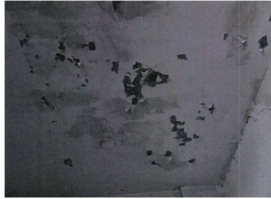
圖 10 建物現況照片 (2)
