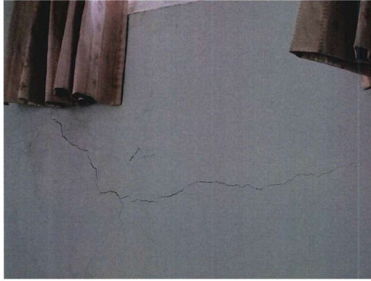
圖 9 建物現況照片 (1)
