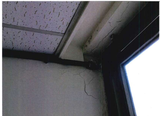
圖 14 建物現況照片 (6)
