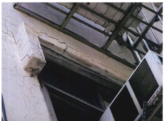
圖 13 建物現況照片 (5)
