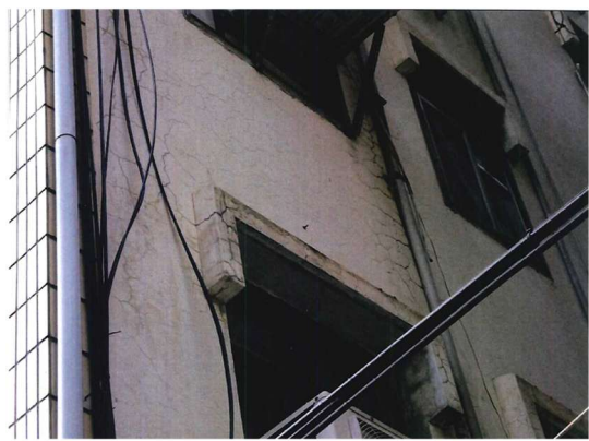
圖 12 建物現況照片 (4)
