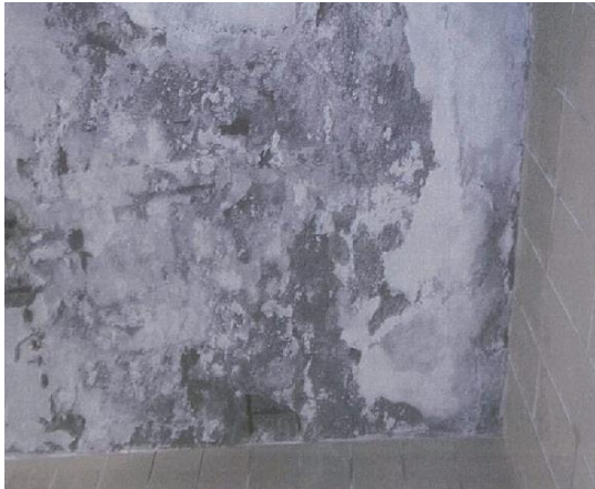
圖12 建物現況照片 (3)
