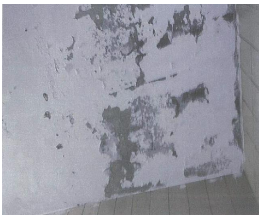
圖10 建物現況照片(1)
