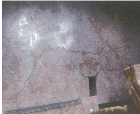
圖13 建物現況照片 (4)
