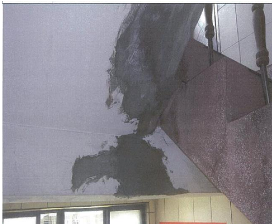
圖14 建物現況照片 (5)
