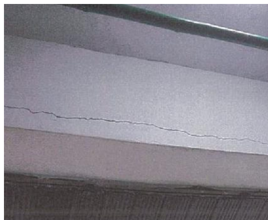
圖11 建物現況照片(2)
