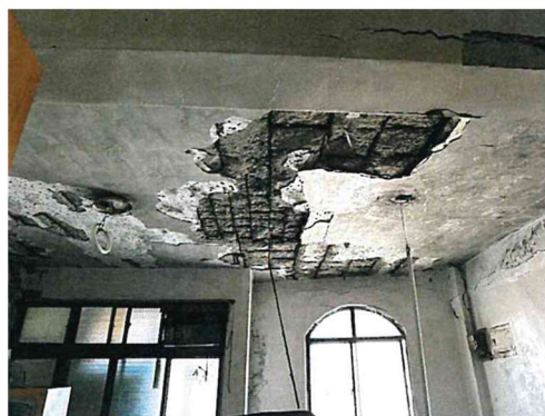
圖12 建物現況照片 (2)
