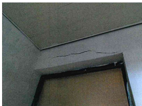
圖14 建物現況照片 (4)
