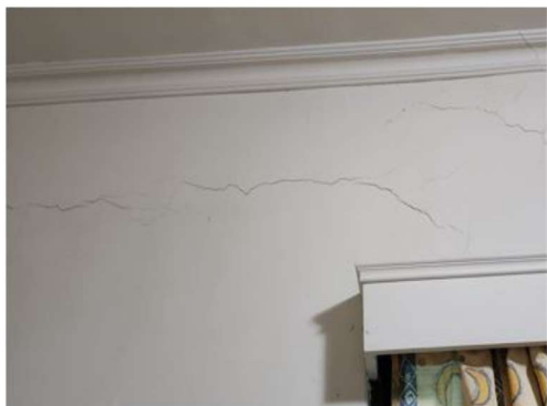
圖16 建物現況照片 (7)
