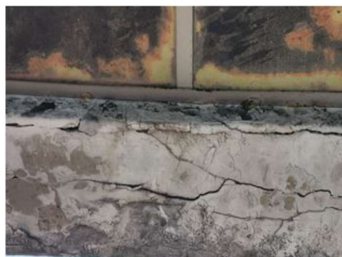
圖17 建物現況照片 (6)
