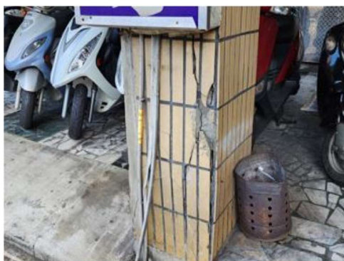
圖15 建物現況照片 (5)
