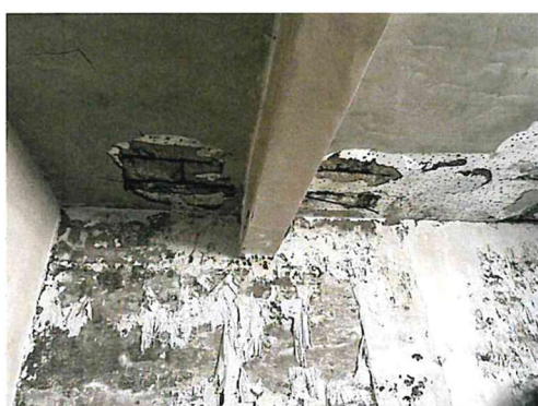
圖11 建物現況照片 (1)
