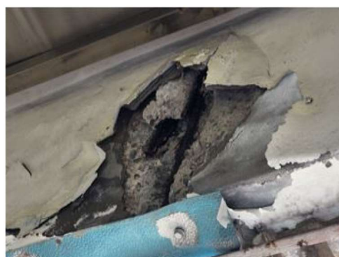
圖18 建物現況照片 (8)
