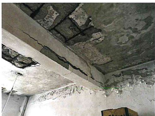
圖13 建物現況照片 (3)
