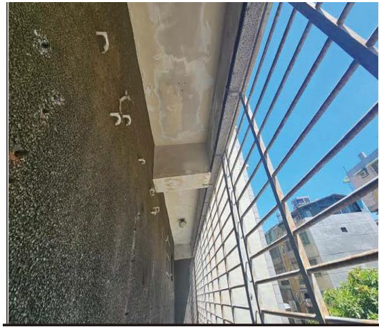
圖 9 建物現況照片(2)
