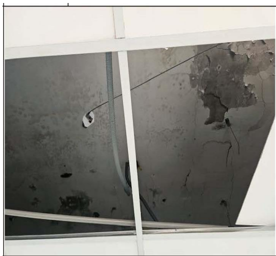
圖 12 建物現況照片(5)
