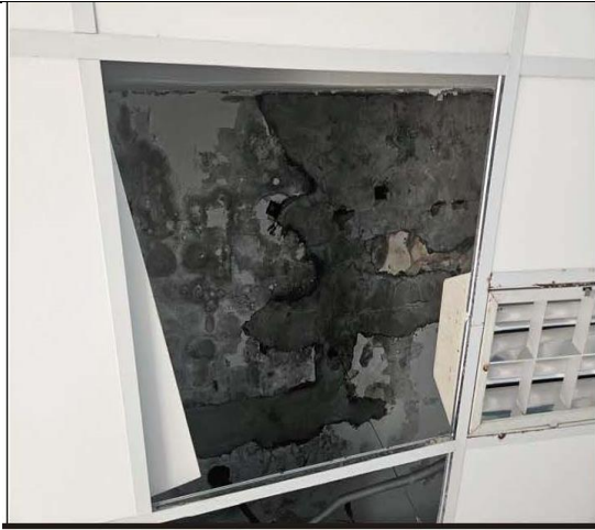
圖 14 建物現況照片(7)
