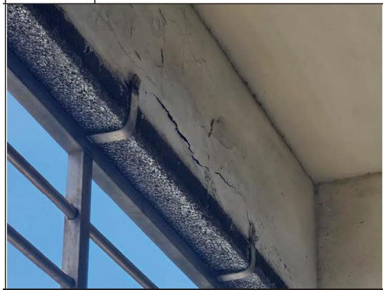
圖 17 建物現況照片(10)
