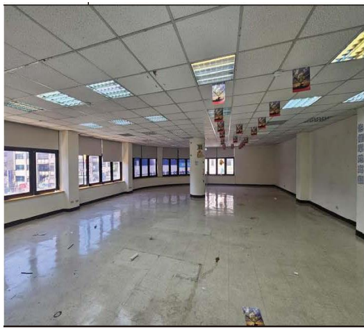
圖 8 建物現況照片(1)
