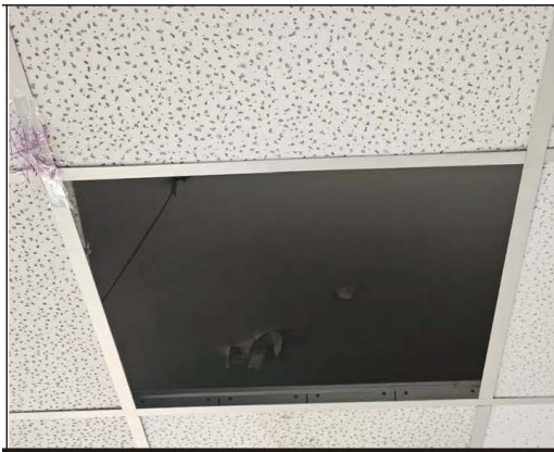
圖 16 建物現況照片(9)
