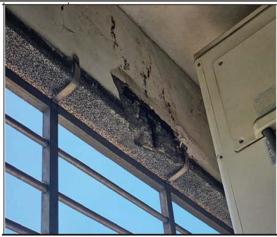
圖 15 建物現況照片(8)
