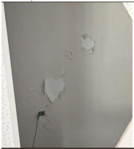
圖 10 建物現況照片(3)
