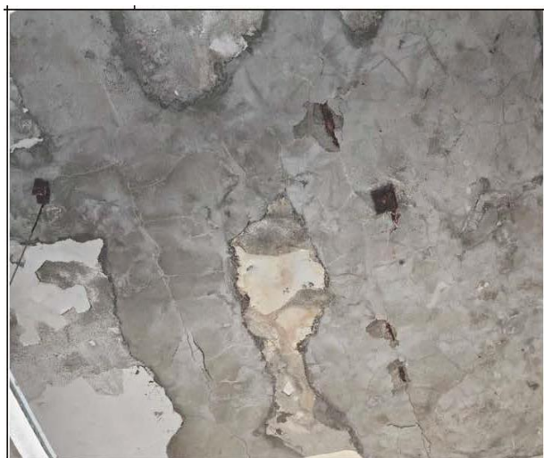
圖 13 建物現況照片(6)
