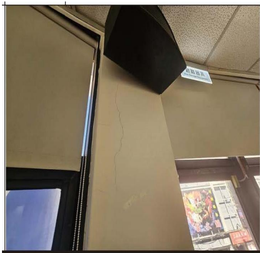
圖 11 建物現況照片(4)
