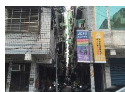
汽機車占據之消防通道
