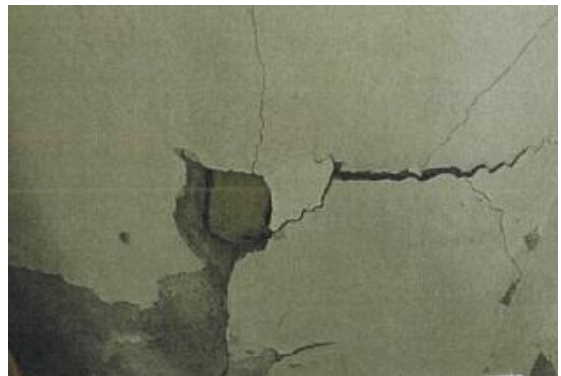
圖13 建物現況照片(6)
