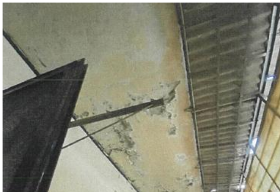
圖12 建物現況照片(5)
