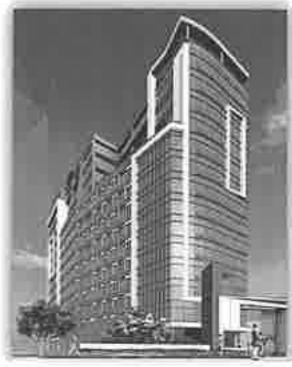
土城區員仁段(永寧站)(基礎工程施作中)
