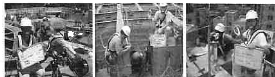
電鍍中電流及電壓查驗 電鍍後會同 NDT 檢測 電鍍後安裝精度檢測
