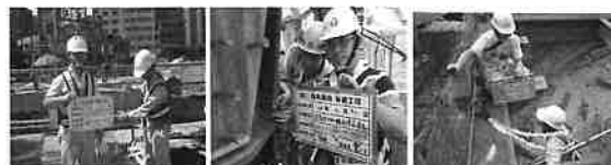
鋼構件進場查驗 電鍍前開槽角度及間隙查驗 高強度螺栓接合扭力檢測
