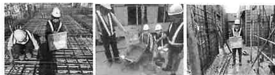
版筋綁架查驗 混凝土澆置查驗 澆置後養護
