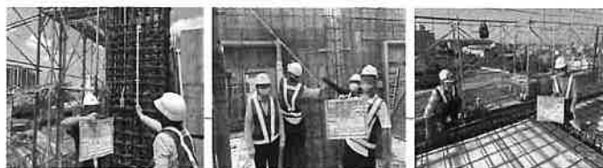
版筋綁架查驗 混凝土澆置查驗 澆置後養護
