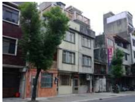
建物有傾頹朽壞情形
