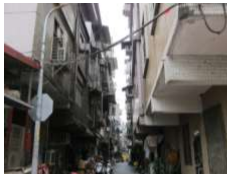
鄰棟間隔不足
