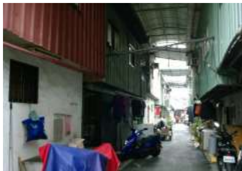
建物排列不良
